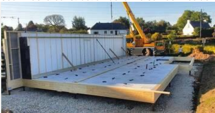
Jour 2 de la construction de la maison de Nicolas Le Dirach. (Photo : MBC 56)
