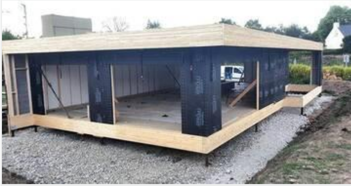
Jour 3 de la construction de sa maison. (Photo : MBC 56)
