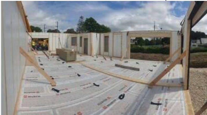
La maison en cours de construction. (Photo : MBC 56)
